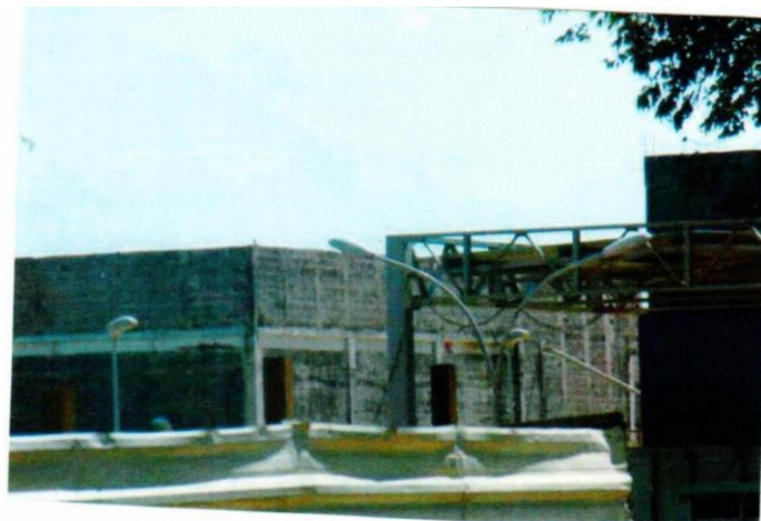
Figure 7 Chantier de l'Hôpital général de Djambala
