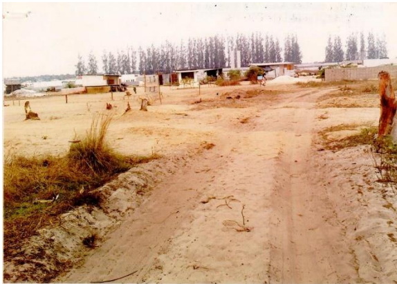
Figure 5 Chantier Hôpital général du quartier 8, Pointe Noire
