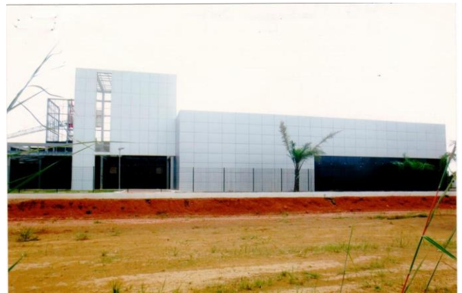
Figure 6 Chantier de l'Hôpital général de Madingou
